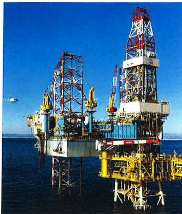
Imagen 2: Plataforma Jack-up durante operación de perforación de pozos en Castor. Feb-2012
