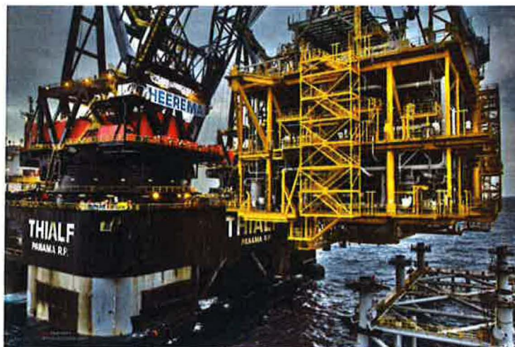
Imágenes 1 a/b: HLV (Heavy Lift Vessel) SSCV THIALF durante operación de montaje de top side de plataforma de operación. Nov-2011
