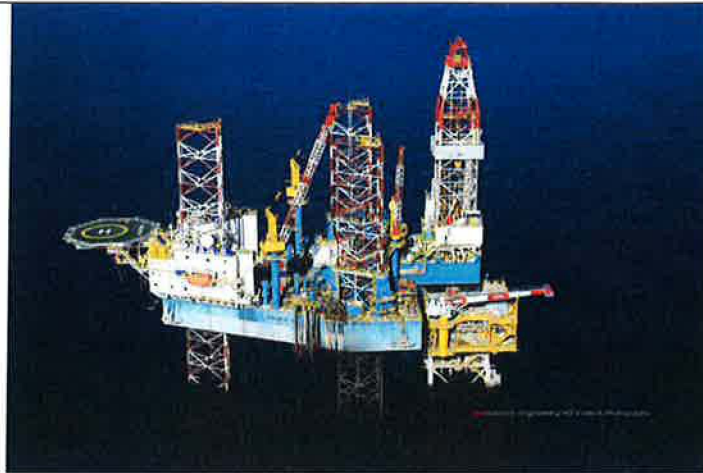
Imagen 9: Jack-up HAKURYU-10 durante operación de perforación de pozos en Castor. Nov-2010
