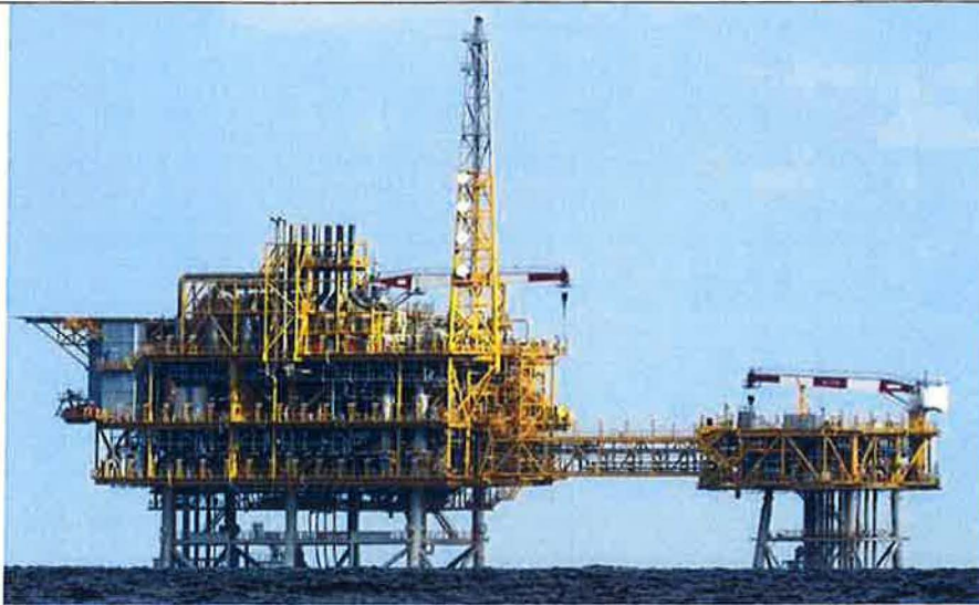
Imagen 6: Vista general plataformas PUQ, WHP y pasarela.
