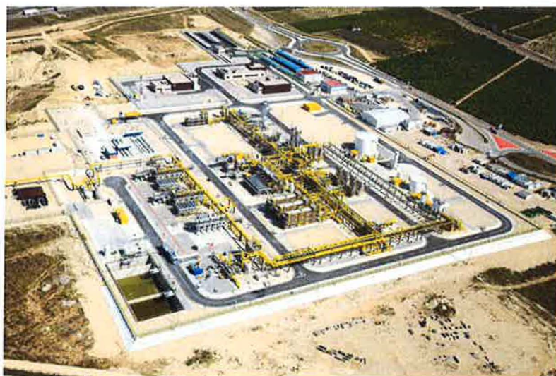
Imagen 4: Imagen aérea planta de operaciones Ignacio Pérez y Posición de válvulas 15.03D.01 de Enagás. Abr-2012
