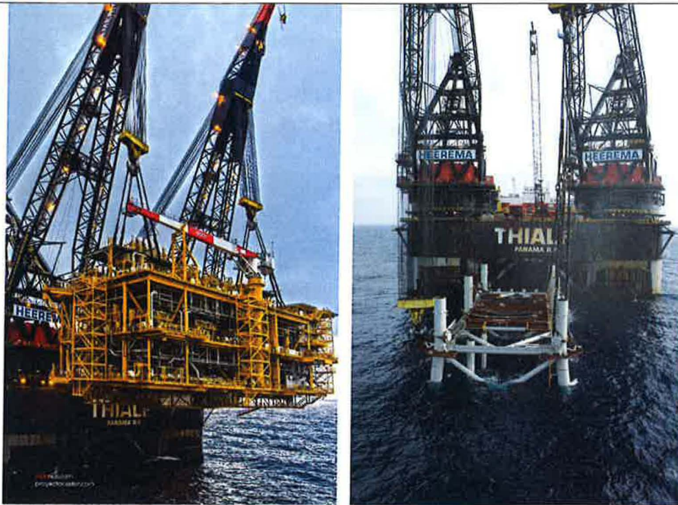
Imagen 11 a/b: HLSSCV THIALF durante carga de topside y montaje de jacket de la plataforma PUQ. Nov-2011
