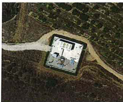
Imagen 5: Block Valve Station (Posición de seccionamiento).
